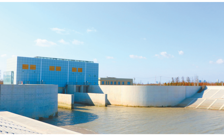
浦东北部规模最大的泵闸严家港泵闸目前已基本建成。 □区河长办 供图
