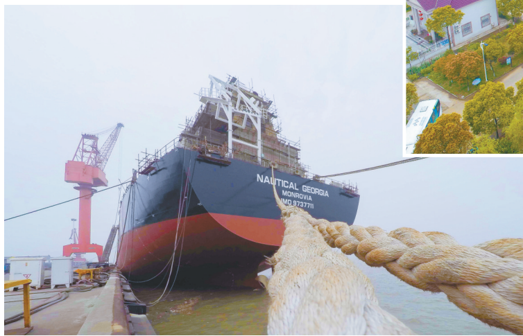
▲扬中市的新韩通船舶重工有限公司是国内一流的现代化船舶和海洋工程建造基地。
